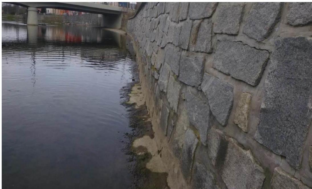
Detailní pohled na zdivo ze žulového kamene zárubní zdi.
