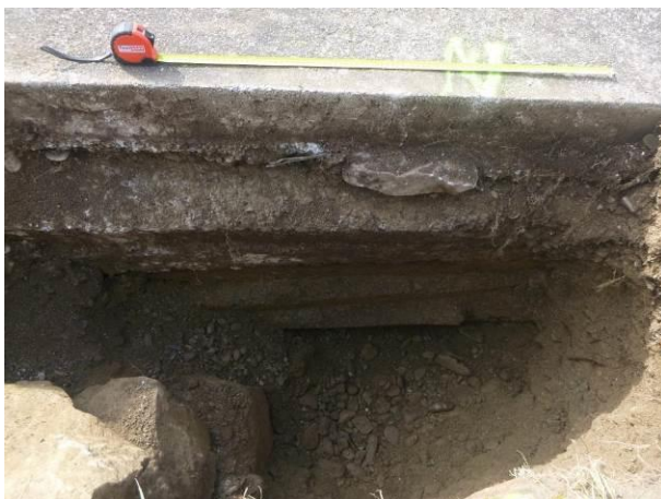
Povrch betonu rubu zdi je nerovnoměrný z bednění.
