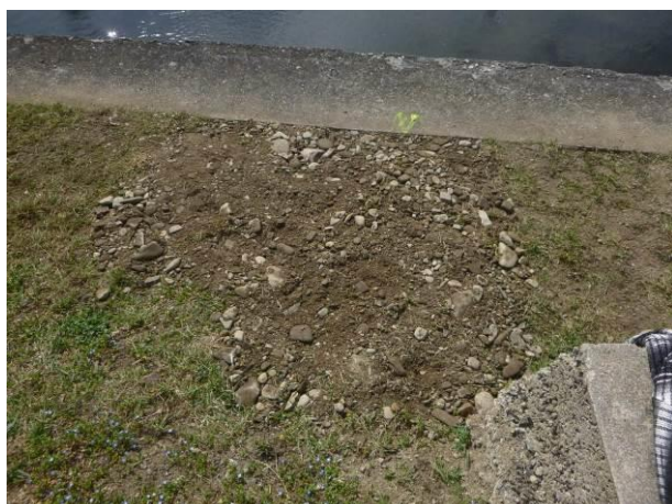
Pohled na zpětný zásyp kopané sondy.
