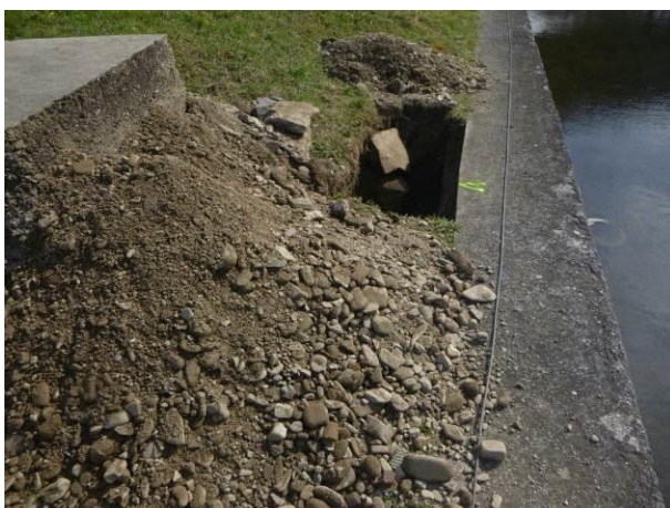
Zeminou je říční štěrkopísek frakce 0/63 s kameny a balvany.
