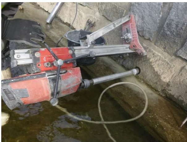
Pohled na jádrové vrtání do paty v profilu p1.
