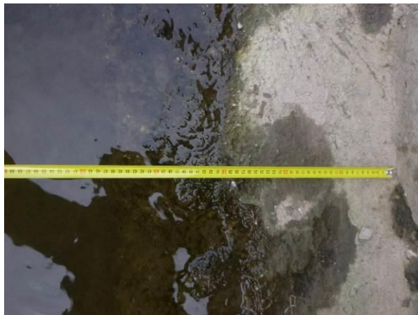
Rozšíření základu bylo v průměru naměřeno 500 mm.
