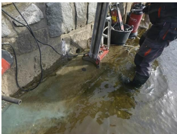
Pohled na vrtání jádrem do základu.
