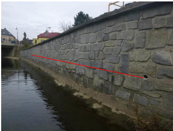
Pohled na odvodnění zdi. Endoskopem byla detekována podélná drenáž za rubem zdi.
