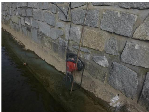
Zjišťování profilů p1 a p2 bylo prováděnou vrtáky délky 80 a 150 cm.
